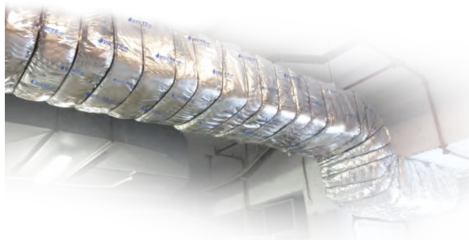
תעלת פח ממוגנת ביריעה קרמית מסוג DUCTZ120™
